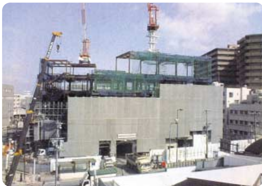
▲ (仮称) 西淀川区複合施設建設工事写真
