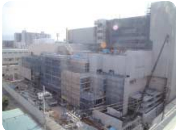
鶴見複合施設建築風景(新鶴見図書館は1階部分)
